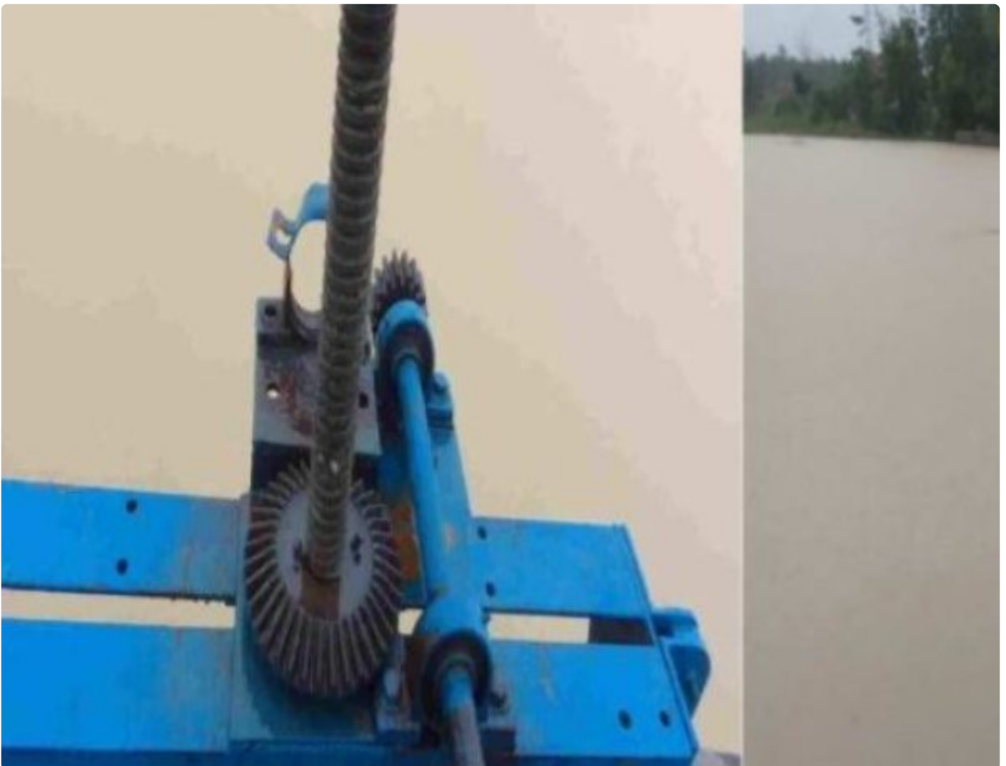
Pintu air Albaret Simpang Mesuji
