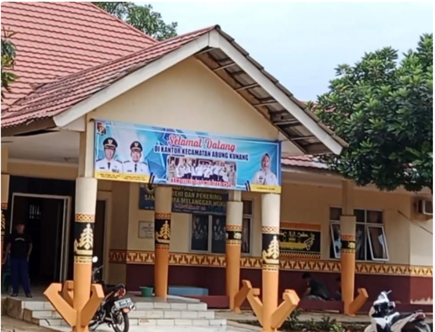
Kantor Camat Abung Kunang Kabupaten Lampung Utara
